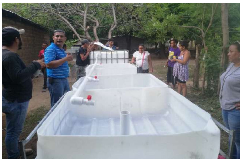
Sistema de acuaponía ya conectados todos sus componentes para comenzar la fase de introducción de los peces y plantas.
