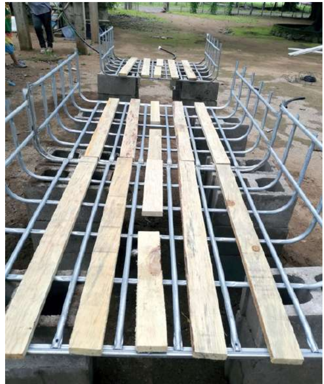
Colocación de reglas de madera en el marco metálico del contenedor para plantas.
