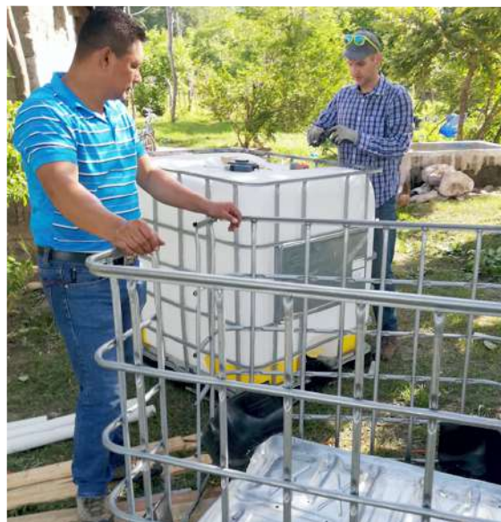
Lo primero es extraer el depósito para iniciar las otras labores.
