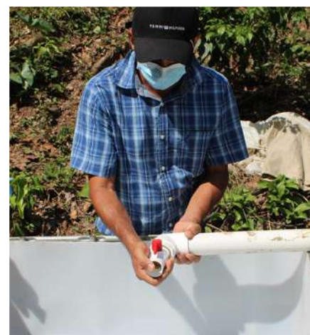
Tubería instalada en la parte inferior de cada uno de los depósitos en el recorrido o movimiento del agua del sistema.
