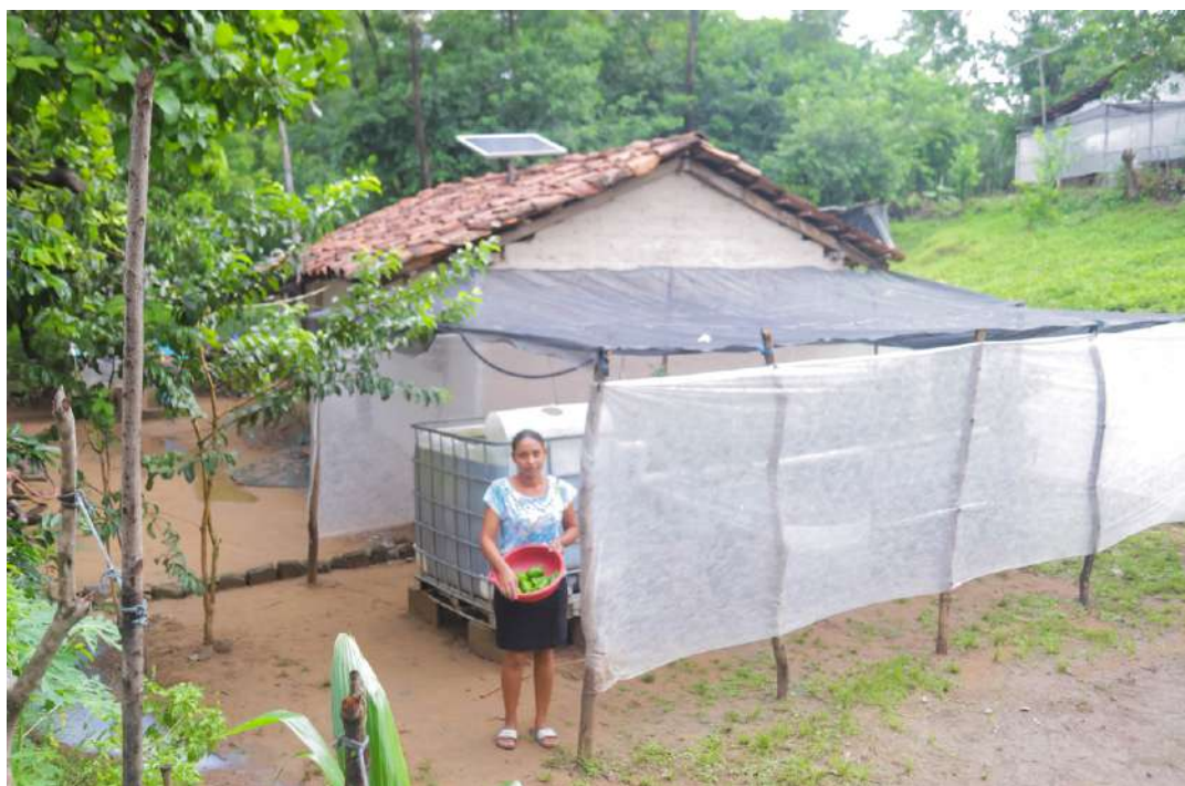
Tipo de techado con el uso de malla de sombreo y térmica en los sistemas de acuaponía en la región sur de Honduras
