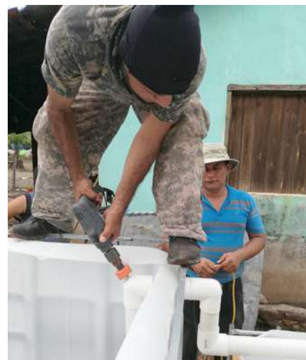
El agujero se hace en el ángulo superior del interior del tanque.
