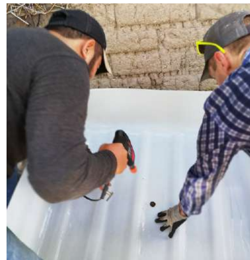
En cada macetera de plantas se debe instalar un sifón de campana en el centro del depósito.
