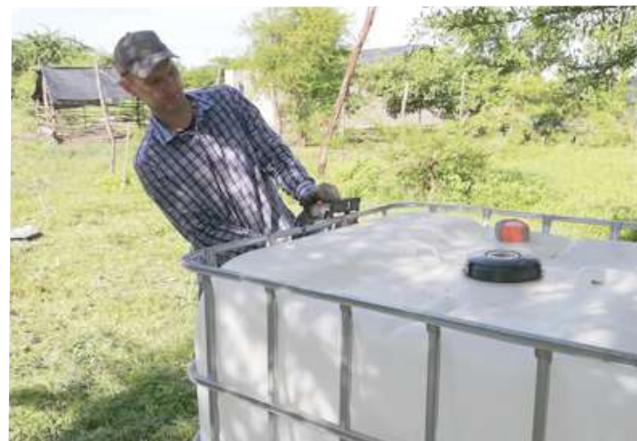
Corte y retiro de barras horizontales metálicas del tanque.
