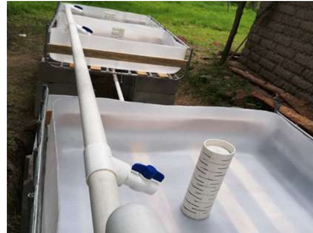
El sifón de campana va colocado al centro de cada macetera, sirve para activar el llenado y vaciado del agua.
