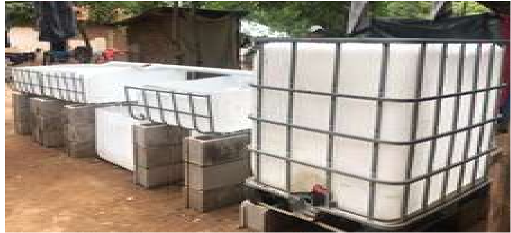
Tipo de sistema de acuaponía de tamaño familiar. Su instalación resulta práctica al igual que las labores de manejo.
