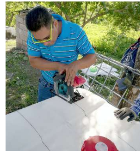
Corte del tanque a lo largo de ambas líneas trazadas para los dos primeros contenedores de igual tamaño.
