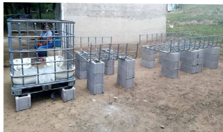
Espaciamiento de las columnas de bloques donde se monta el sistema una vez instalado y conectadas las tuberías de llenado y drenaje de agua.
