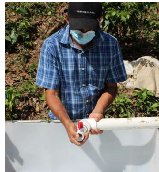
Instalación de tubería en tanque de peces.
