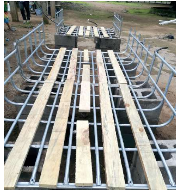
Forma de colocar las reglas de madera entre los soportes de metal sobre los cuales van las maceteras
