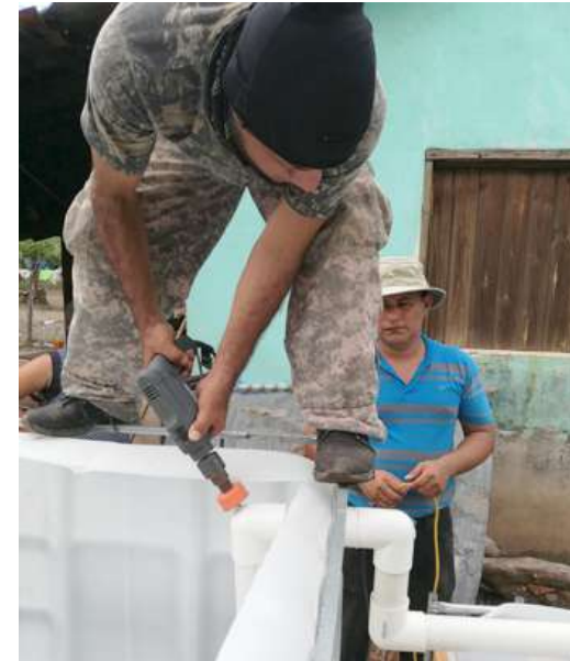
Perforación de ángulo superior en tanque de peces.
