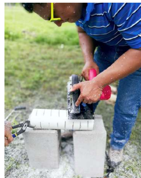
Perforación de las ranuras en el tercer tubo del sifón de campana
