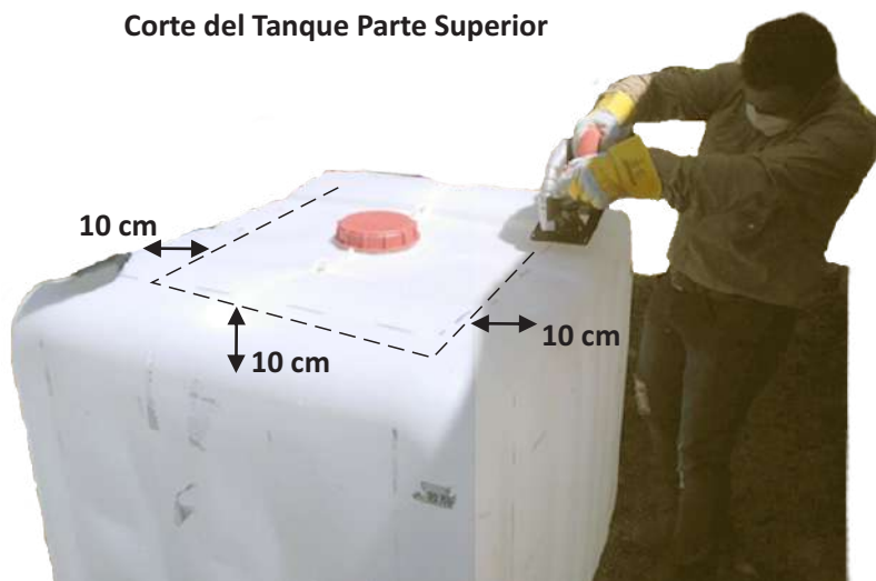
Sobre las líneas trazadas, se hace el corte en la parte superior del tanque para la pecera.
